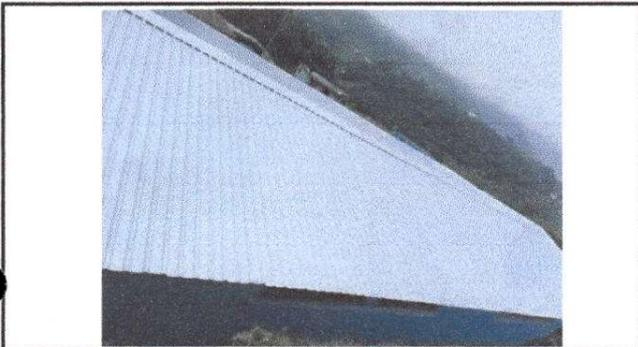
Foto 1: Instalacion de Lamina troquelada aluzinc calibre 26 modulo 2
